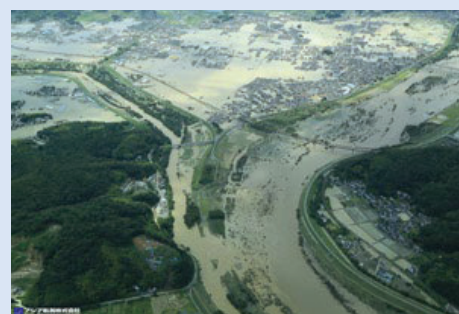
2018年7月8日14:56撮影 岡山県倉敷市真備町
