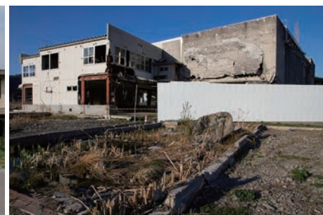
一部解体工事着手 2014年4月12日撮影
