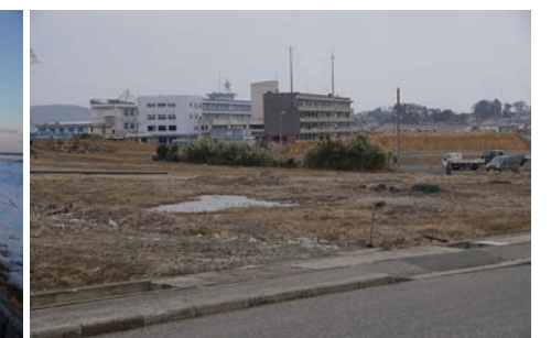
気仙沼処理区仮設焼却場撤去 2014年3月16日撮影
