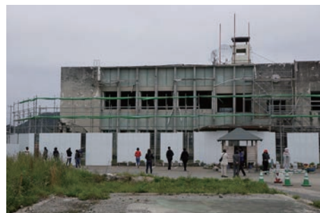
本体解体工事着手 2018年6月17日撮影
