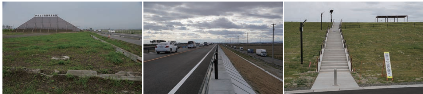
東部復興道路工事現場 2013年7月27日撮影
