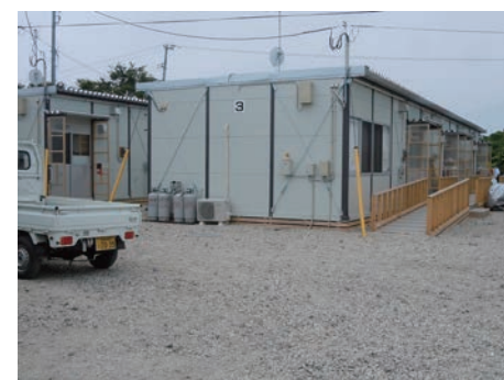
桂島応急仮設住宅 2011年7月19日撮影
