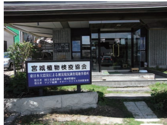
東日本大震災による被災現況調査(宮城5工区) 塩竈事務所 2011年6月30日撮影
