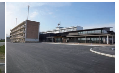
気仙沼市東日本大震災遺構・伝承館 オープン 2019年3月10日撮影
