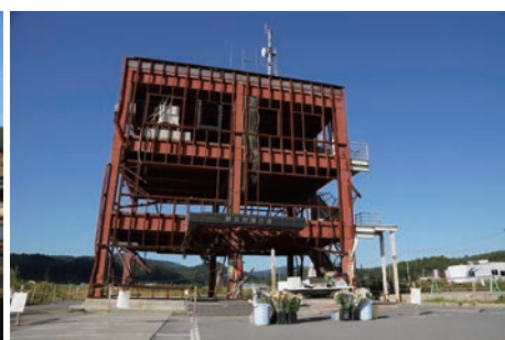
2年半後の防災対策庁舎 2013年9月28日撮影
