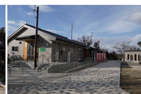
桂島地区災害公営住宅 完成 2015年12月25日撮影
