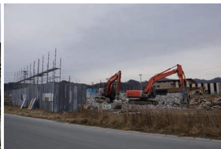
本体解体工事終了 2019年2月3日撮影
