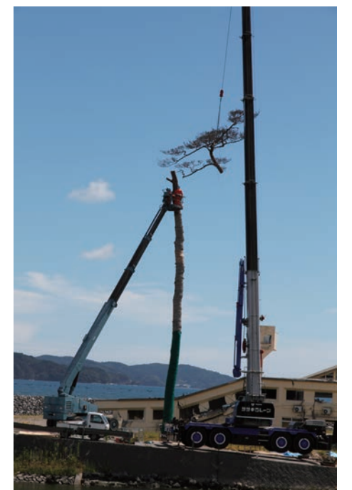
切断工事 2012年9月12日撮影
