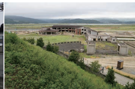
震災遺構工事中 2020年8月22日撮影
