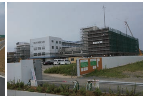
気仙沼向洋高校・伝承館建設中 2018年8月24日撮影
