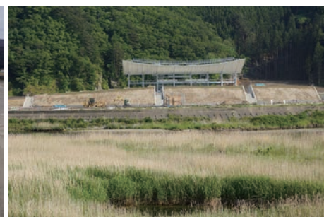
建設中 2018年6月3日撮影
