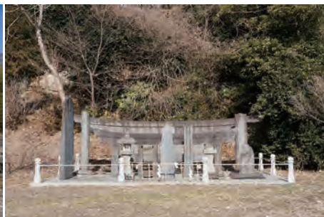
被災した諏訪神社の一部を震災遺構として後世に伝承 2021年2月20日撮影
