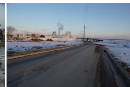
階上地区二次仮置き場設置 2013年1月19日撮影
