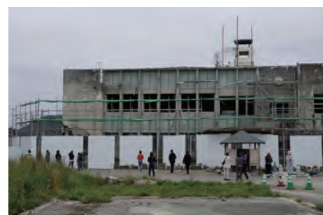
本体解体工事着手 2018年6月17日撮影
