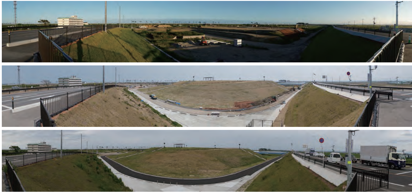
避難の丘の建設現場(上:2019年9月15日撮影、中:2020年5月2日撮影、下:2020年6月13日・完成) 手持ちの一眼レフカメラによるパノラマ写真
