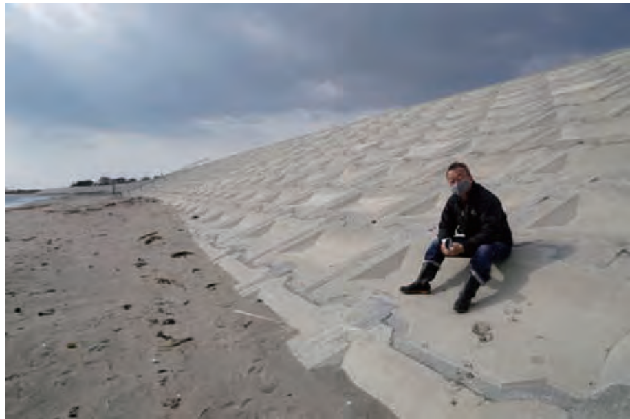
渡邊提案をもとに施工された菖蒲田海岸護岸 2021年2月20日撮影
