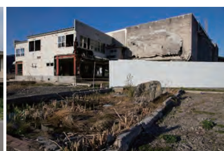
一部解体工事着手 2014年4月12日撮影
