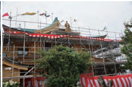
新社殿造営上棟祭 2018年8月5日撮影
