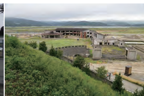
震災遺構工事中 2020年8月22日撮影
