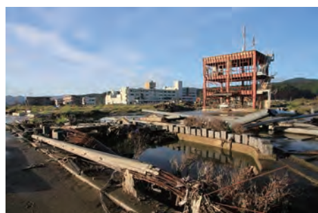
南三陸町防災対策庁舎 2011年9月23日撮影
