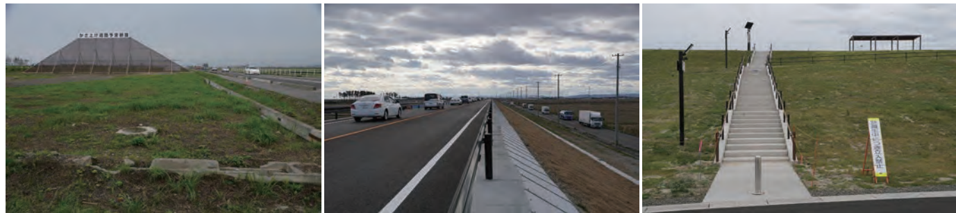
東部復興道路工事現場 2013年7月27日撮影
