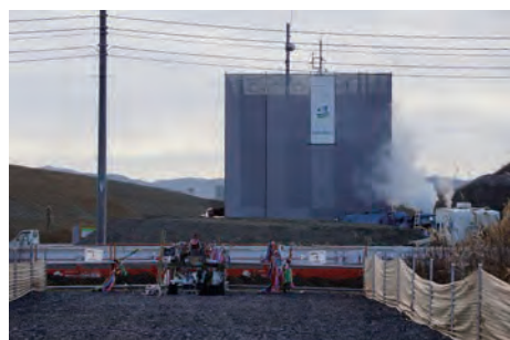
県管理前の保存工事 2016年12月29日撮影
