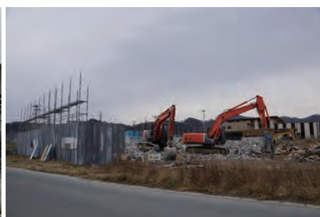
本体解体工事終了 2019年2月3日撮影
