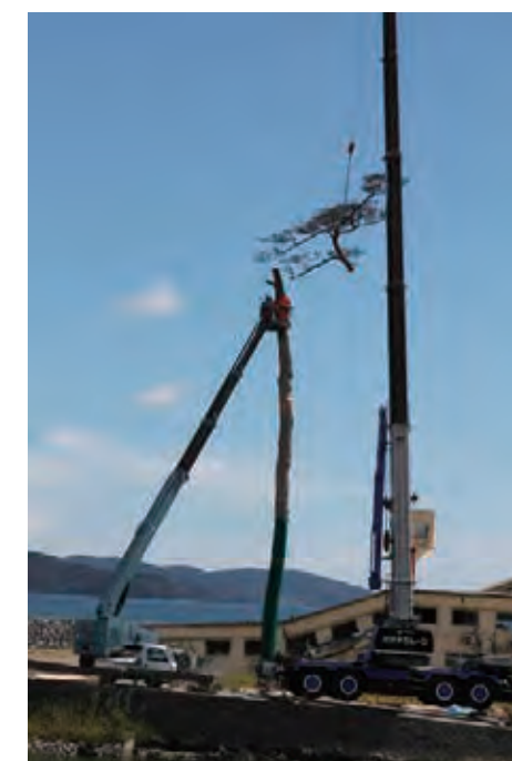
切断工事 2012年9月12日撮影
