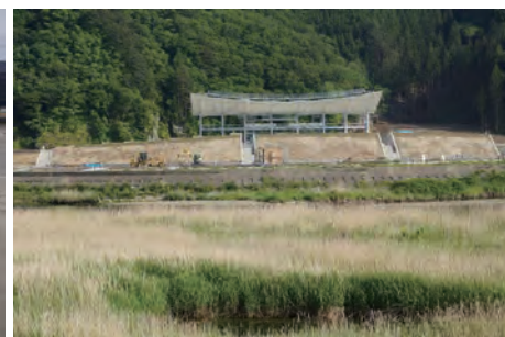
建設中 2018年6月3日撮影
