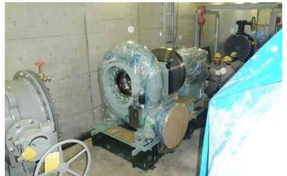
送水管のバイパス管路に水車を接続
