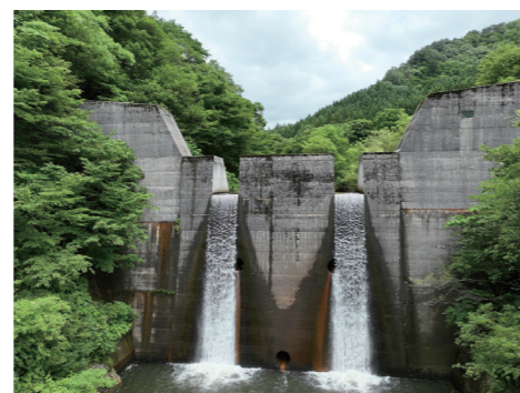
図1 調査対象とした砂防堰堤
