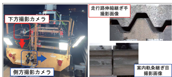
図2 各カメラの設置状況と撮影画像
