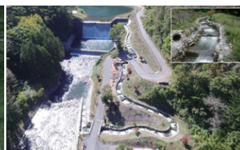
図2 金原砂防堰堤魚道
