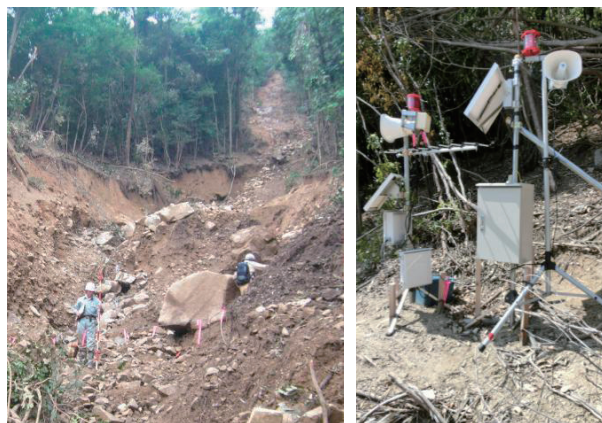
図3 土石流監視警報装置の設置状況
