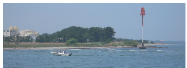
図4 作業対象範囲の現地状況（神通川河口部）
