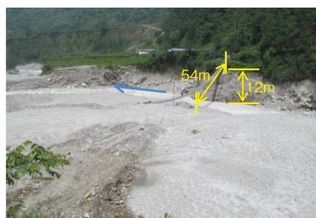
図7 Karpani 吊り橋付近での被害発生
