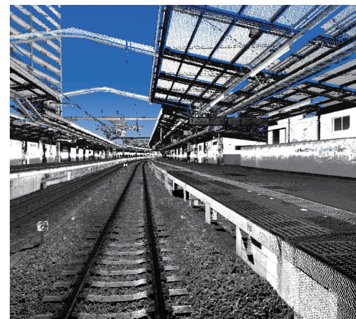
図4 鉄道MMS計測データ（三次元点群データ）
