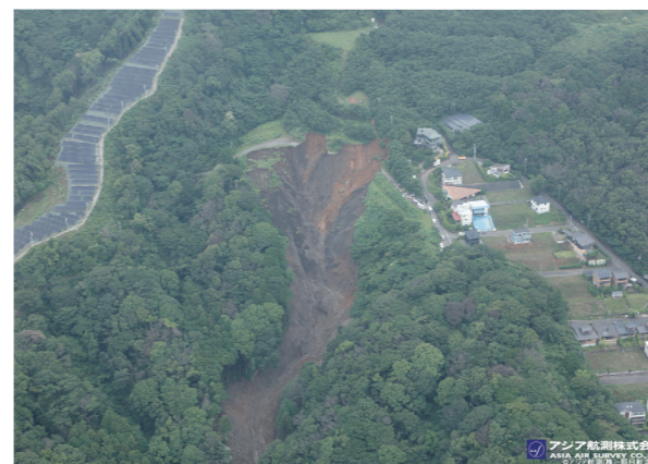
図3 熱海市伊豆山地区の土石流の発生源となった崩壊
