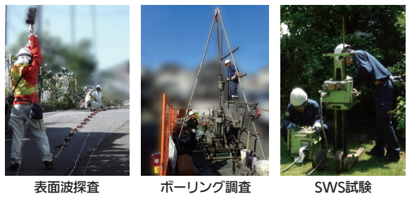
図4 地盤調査の実施状況写真
