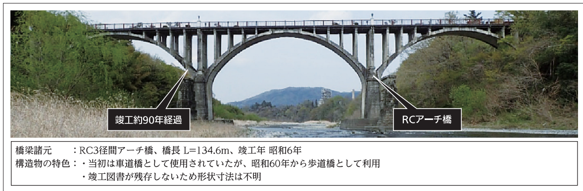
図1 計測対象橋梁
