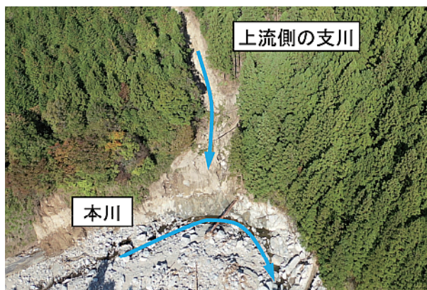
図5 本川上流部の土砂・流木流出の状況
