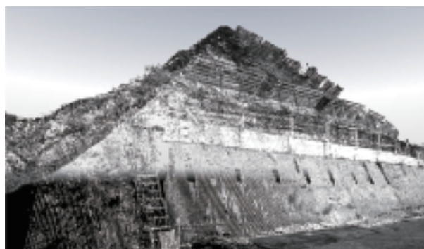
図3 構造物、擁壁、法面、山腹の形状確認
