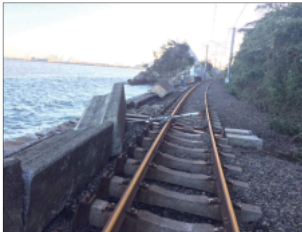
図1 現地被災状況
