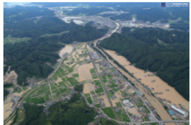
図1 斜め写真（広島県三原市本郷町付近、2018年7月8日撮影）
