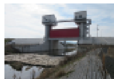
図5 現地における水門の敷設状況写真（右）
