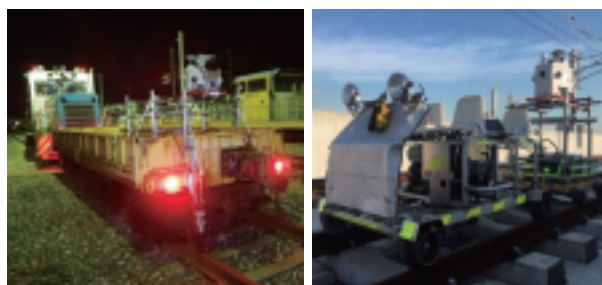
図3 計測作業の様子 (左：保守用車、右：軌道自動自転車)
