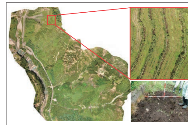
図4 山腹工オルソ画像および被害状況
