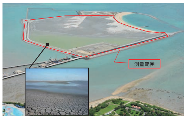
図1 水域を含み軟弱な地盤が広がる土砂処分場
