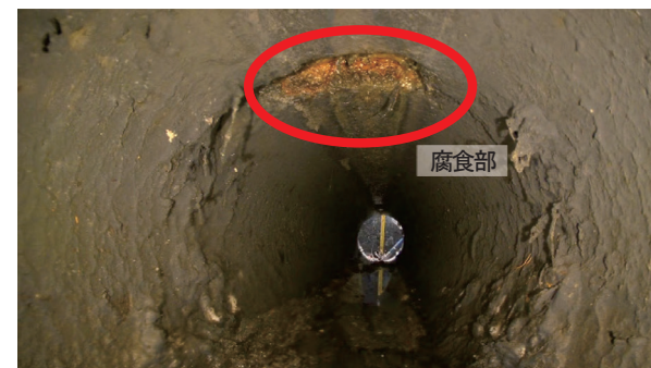
図4 管内撮影結果（腐食部）
