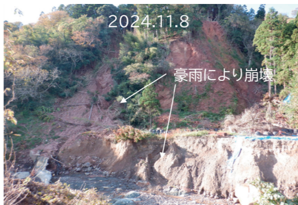
図2 深見川河口左岸の側方侵食と土砂崩壊
