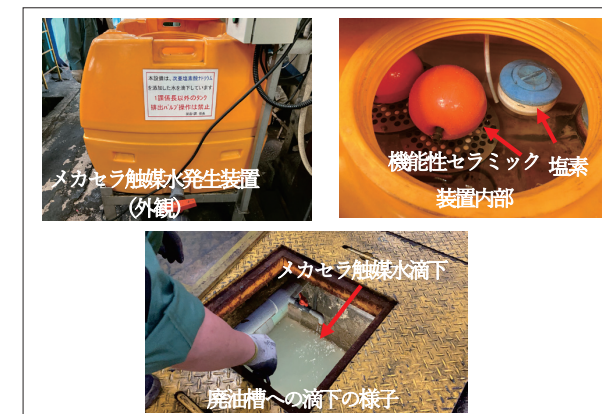
図4 工場廃油槽への導入事例
