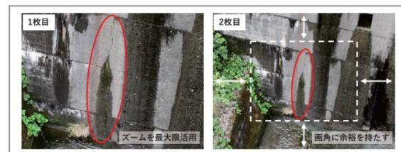
図2 変状撮影時のズーム倍率設定例
