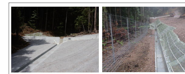
図3 土留工(左)と水路工(右)
