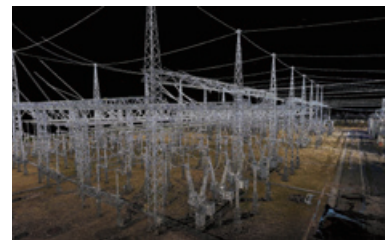
変電所計測データ(地上レーザ)
