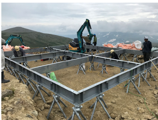
【基礎工事の様子】
