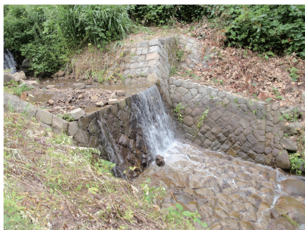
図4 歴史的砂防施設の補修事例
