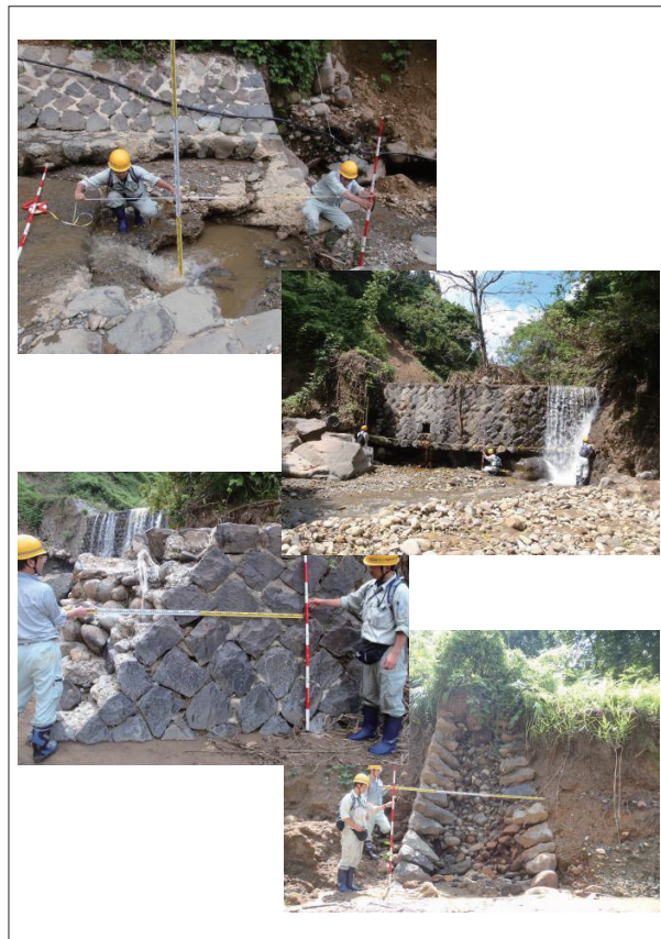
図2 石積砂防えん堤の老朽化・損傷度調査例
