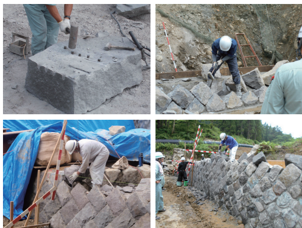
図3 伝統的な石積み技法による補修状況
