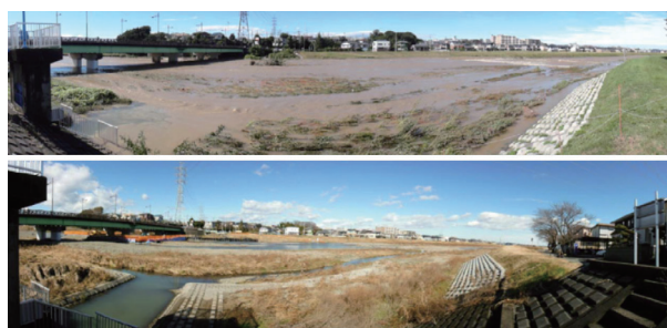
図1 定点写真観測による河道状況の把握 (上：出水期中 下：出水期後)
