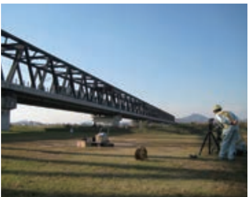
橋梁たわみ計測システム
