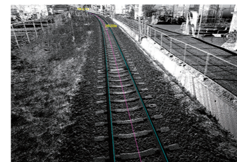
Railisによるレーザ点群と設備自動抽出
