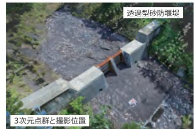
Visual SLAM搭載UAVによる詳細点検
