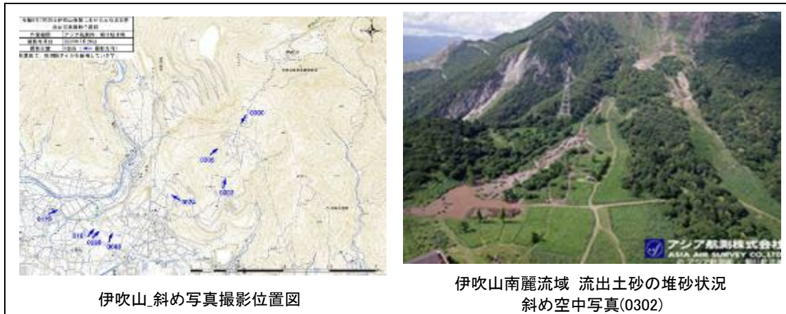
図 5.2 令和 6 年 7 月 25 日からの大雨に関する被害状況（第 1 報）
