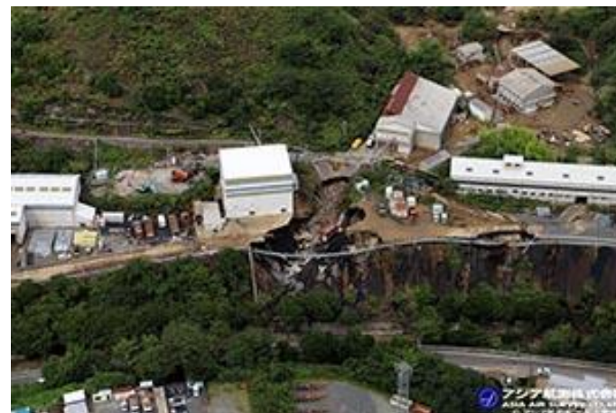
2023年9月8日～台風13号の大雨による被害撮影 (福島県いわき市内郷地区)
