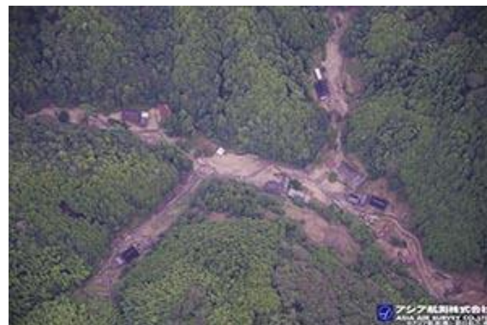
2023年8月8日～台風7号の大雨による被害撮影 (舞鶴市桑飼上付近)
