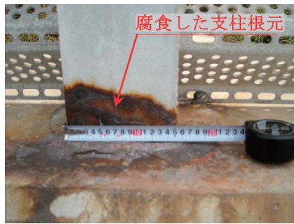
図2 防風柵支柱の劣化状況
