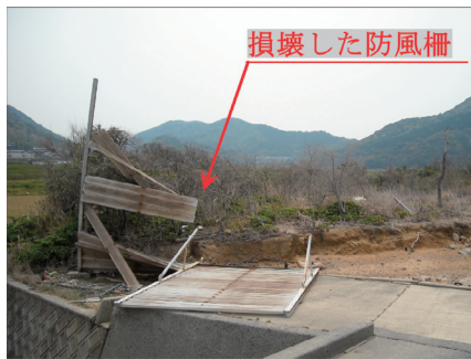
図1 防風柵の損壊状況
