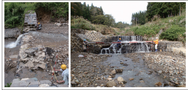
図3 災害復旧に向けた被災施設の調査
