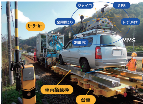
図1 線路における計測状況
