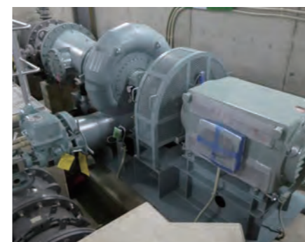
小水力発電 (馬越石水力発電所|株式会社アクアパワー東北)
